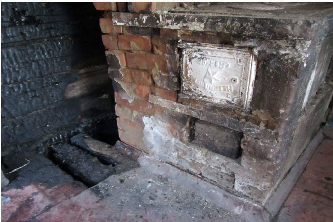
Результат выпавшего уголька из-за не проведённого вовремя ремонта печи
